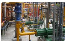
**Pumpen & Belüftung.** Pumpen und Belüftungen – etwa in Schwimmbädern, Kläranlagen oder Fernwärmenetzen – können innerhalb definierter Grenzbereiche flexibel betrieben und so für die Erbringung von positiver und negativer Regelreserve genutzt werden.
