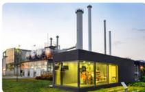
**Power to Heat-Anlagen.** Hybride Heizsysteme, die bei Stromüberschuss elektrische Energie anstatt Brennstoffen zur Erzeugung von Warmwasser oder Dampf nutzen können, eignen sich bestens zur Erbringung von negativer Regelreserve.
