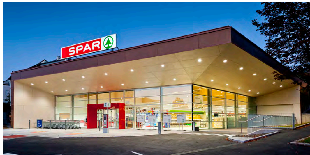
Der Supermarkt der Zukunft in Linz - Froschberg von außen (rechts) und innen (rechts unten) Photovoltaik-Anlage, Linz - Holzstraße (links unten) Bilder: SPAR
