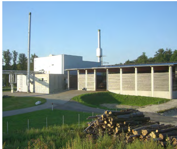
Das Biomasse-Kraftwerk erzeugt Ökostrom und versorgt Spitz sowie die Region Attnang-Puchheim mit Wärme
