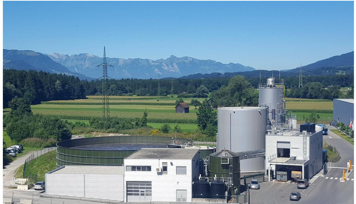
Die bisherige Betriebsabwasserreinigungsanlage (kurz: BARA) in Nüziders reinigte die Produktionsabwässer in einer aeroben biologischen Reinigung auf Direkteinleiterqualität, wodurch die Einleitung in ein Fließgewässer möglich war.
