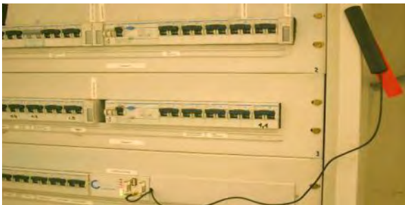
Abbildung 25: GSM-Verbindung zur Übertragung der Daten aus dem Datenkonzentrator
