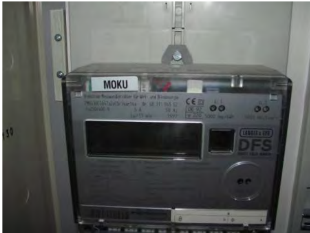
Abbildung 56 (oben): Innenstadthotel, Wien. Subzähler für die Klimaanlage
