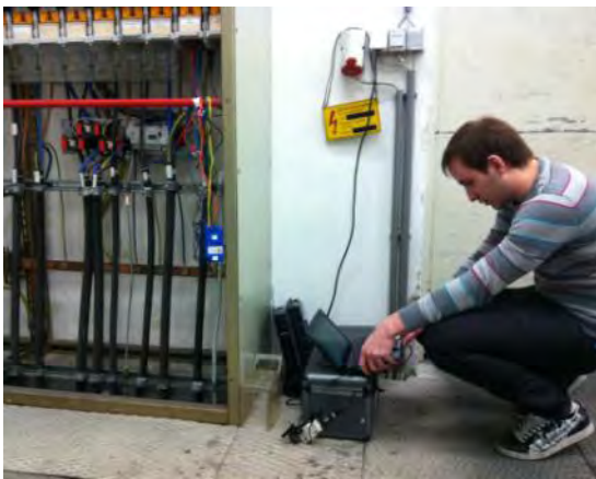
Abbildung 41: Einbau des Messsystems: Überprüfung der Funkkonzentratoren
